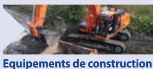
Equipements de construction
